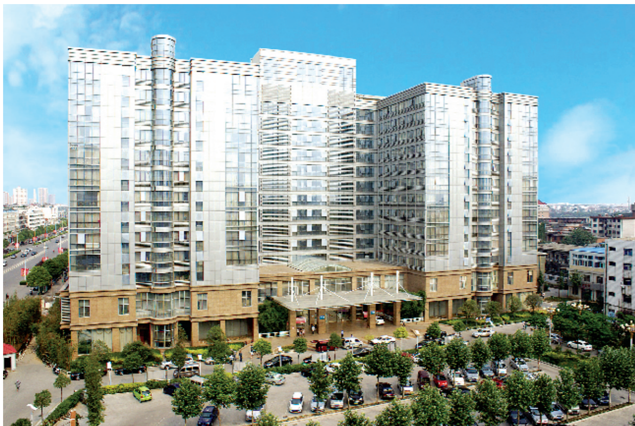
新建成启用的病房大楼内部宽敞明亮、舒适方便。其建筑面积3.6万平方米,设床位1000张,医疗与生活设施先进、完备。地温中央空调使整座大楼四季如春,住院条件达到国内一流。
